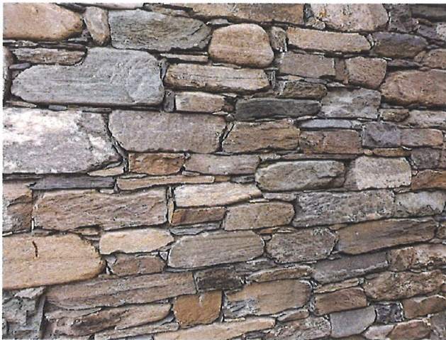
Aspect de la maçonnerie « pierre sèche » projetée pour l'habillage du socle de la croix sommitale
