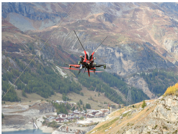
Installation de balises sur une ligne électrique. Commune de Tignes (octobre 2016) © PNV - S. Berthillot
