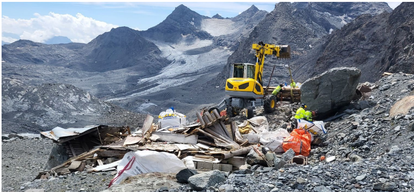
Chantier en cours pour l'évacuation des débris de l'ancien chalet de Thorens Au fond, le glacier de Chavière | S. Brégeon – PNV
