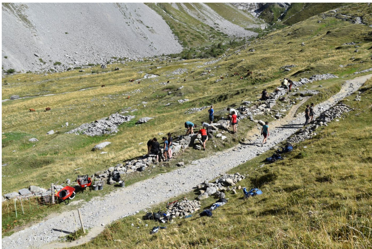
Vue d'ensemble du chantier de réfection des murets de la route du sel à Pralognan-la-Vanoise, du 7 au 11 septembre 2026 | I. Mira - PNV
