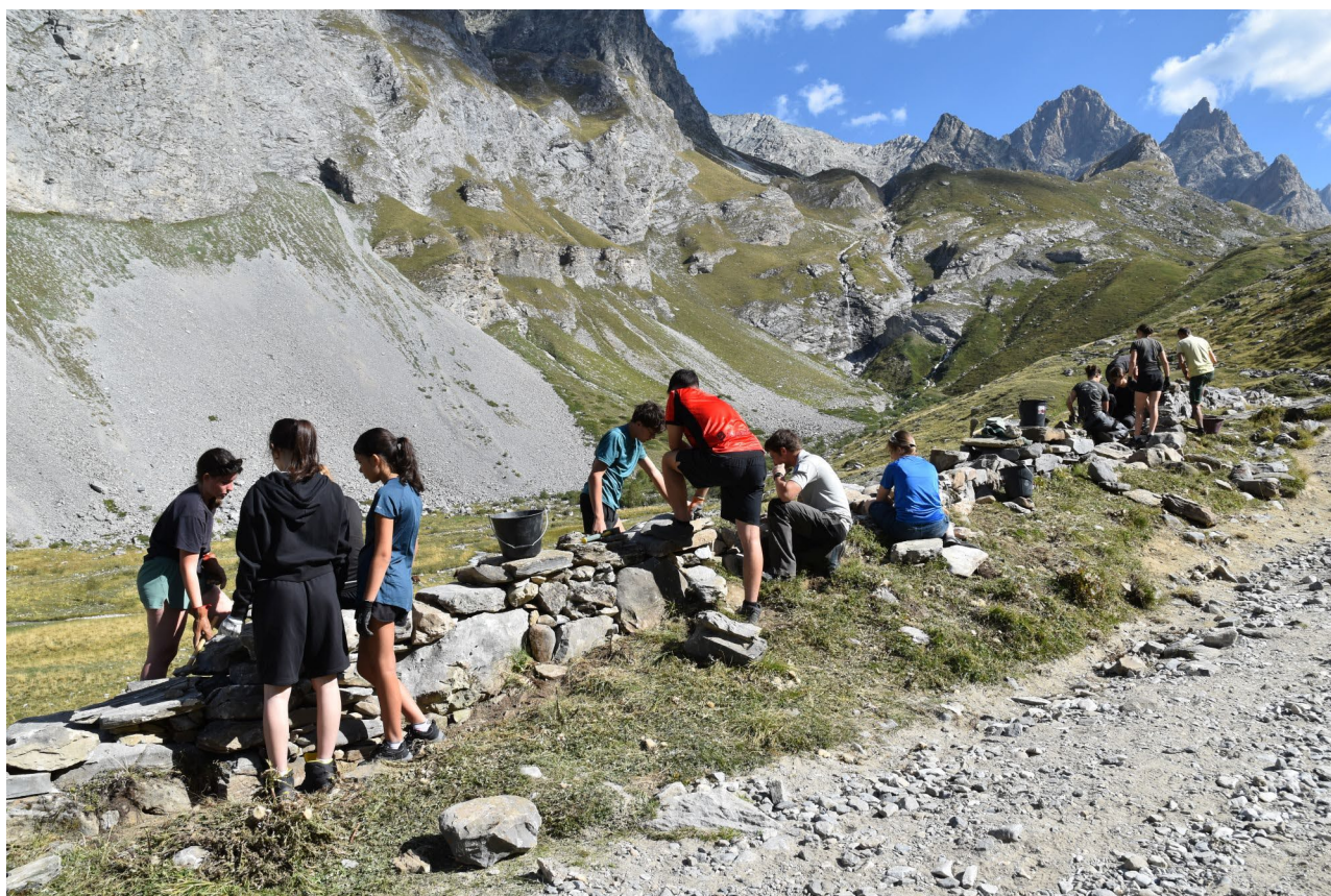
Les élèves du lycée Reinach à l'œuvre avec les Muraillers de Provence et des agents du Parc national I. Mira - PNV
