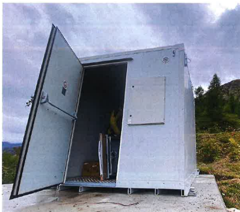
Photographie d'un abri Gazex classique
