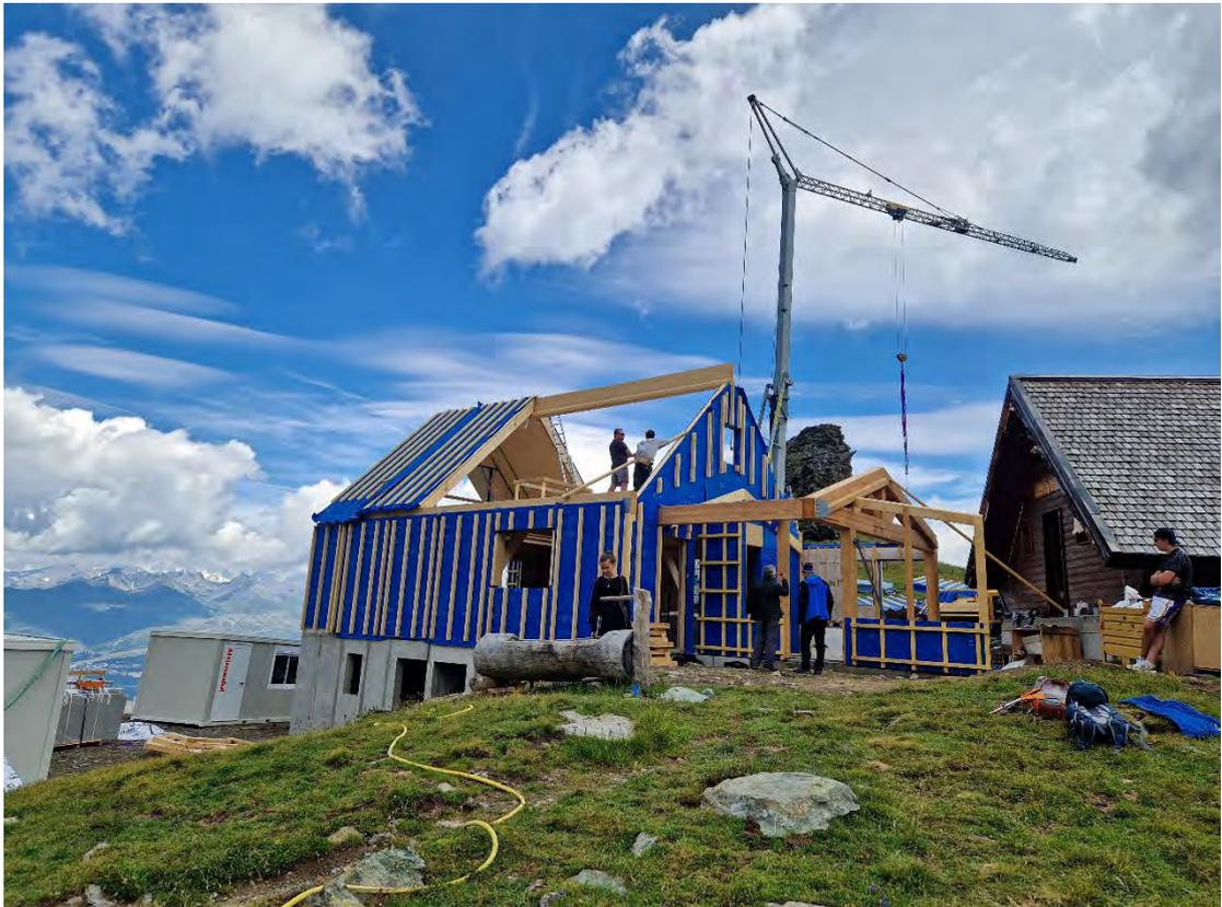
Pose de la partie supérieure de l'extension du refuge, en ossature bois
