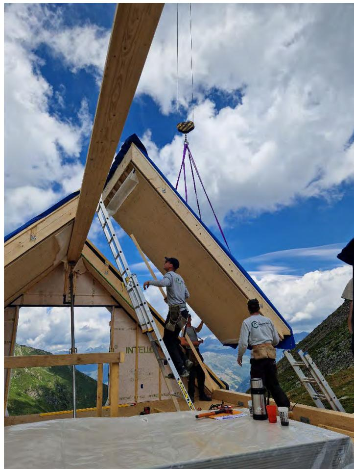
Assemblage des caissons de toiture de l'extension du refuge
