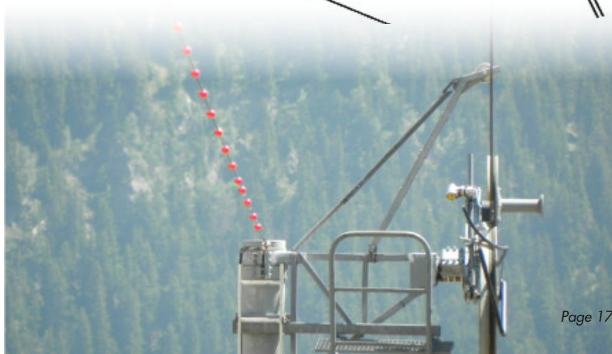
▼ Un télésiège équipé de flotteurs installés sur la cordeline.
